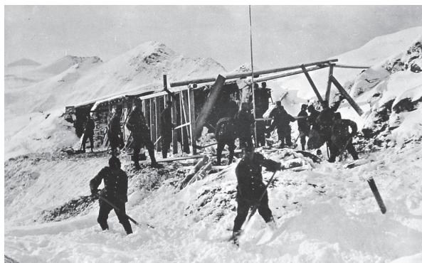
Bau einer Unterkunftshütte im Winter auf dem Pass Umbrail.
